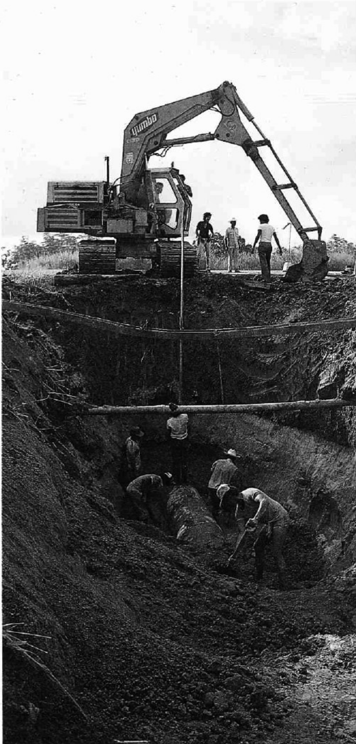
Excavación para conexión de colectores, en Cárdenas, Tabasco.
