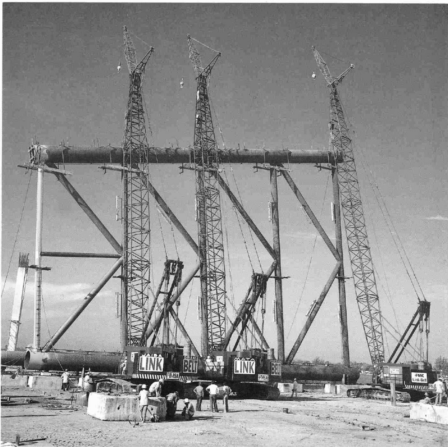
Instalación de una de las plataformas, fabricadas y montadas por FIMSA; izquierda, detalle de una plataforma marítima en funcionamiento.
